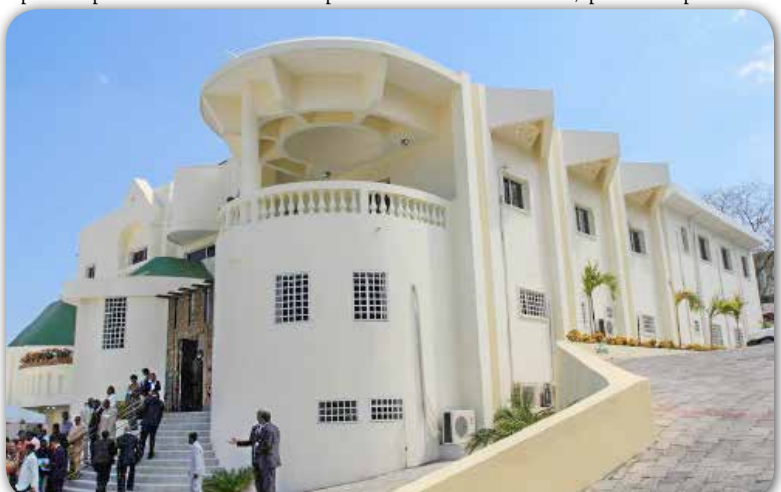
Le bâtiment de la Cour Supérieure des Comptes et du Contentieux Administratif (CSC/CA),
