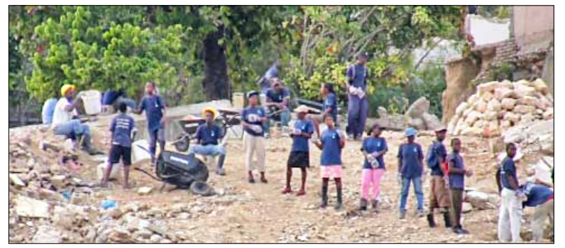
Les travailleurs CFW d'une autre organisation - Project Concern International - vident les décombres un bloc et un seau à la fois. Photo: HGW
