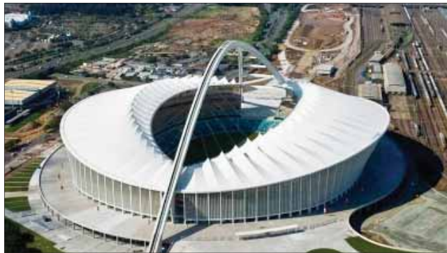
On ne sait pas comment fera l'Afrique du Sud pour maintenir en activité ces géants de béton, un gaspillage multimillionnaire...
