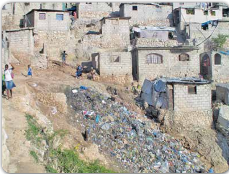
Ces logements ne sont pas confortables, ont moins de trois pièces et n'ont pas accès aux services telles que de l'eau, de l'électricité et du lieu d'aisance et ne répondent pas aux normes minima d'Habitat
