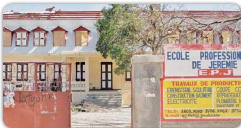
Cette école professionnelle de Jérémie dépourvue de toiture après le passage de Matthew
